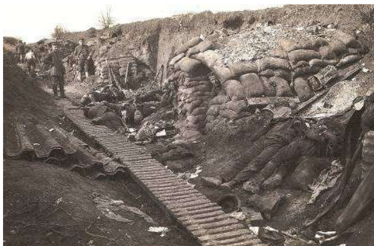
Image de tranchée © DR
